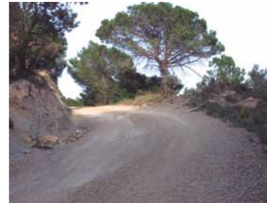
Arranjament d'un tram del camí de la Barroca- TM Sant Aniol de Finestres
